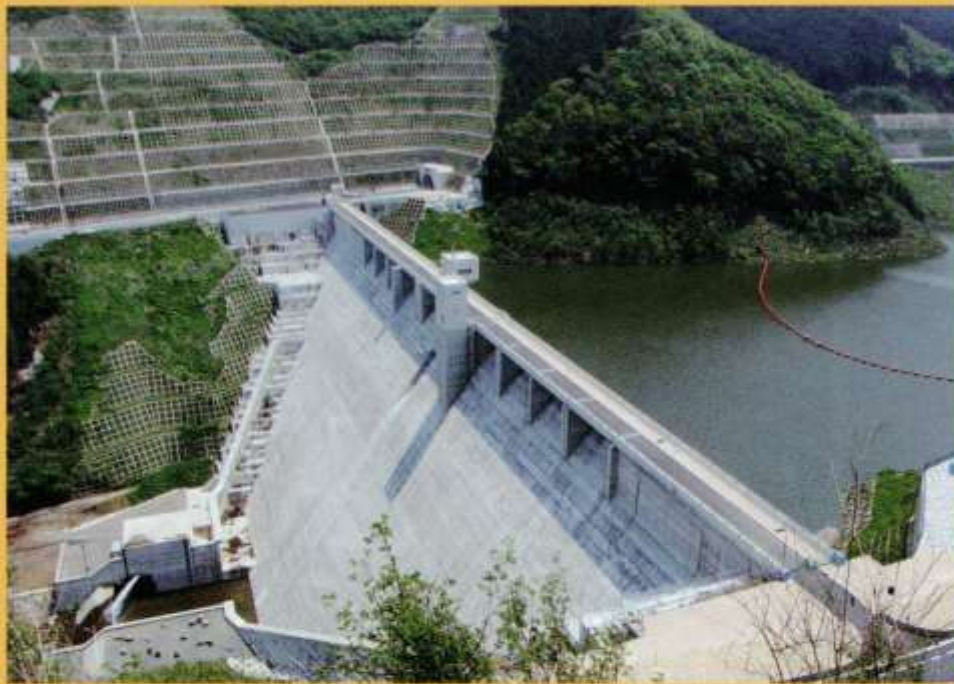
左岸側よりダム本体を望む
