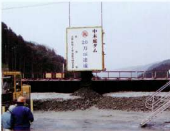
20万立方メートル打設 (H17.2)
