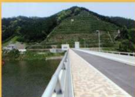
ダム天端道路
