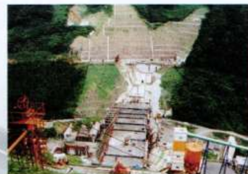
左岸より壁打設工事状況 (H16.9)
