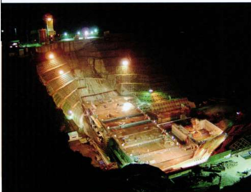
夜間打設 (H16.8)
