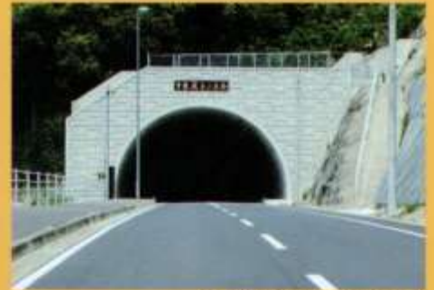
中木庭トンネル (国道444号)
