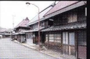
⑧庄金(しょうぎん)の町並み: 旧多良海道沿いの両側町として発展し、江戸時代には商人や船乗り、銀治屋等が住み、佐賀・長崎を結ぶ陸と海の交通拠点でもありました。往時の奥行きが深い土地形状を良く残し、連続する茅葺や桧瓦葺の町家を特色とします。
